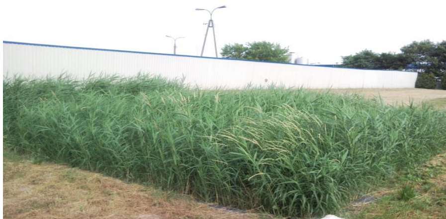
Rys. 4. Złoże hydrofitowe o przepływie pionowym-jako element instalacji wdrożeniowej do oczyszczania odcieków –Bielmlek Bielsk Podlaski
