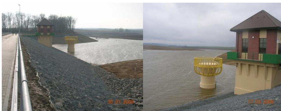
Rys. 2. Zbiornik Włodzienin – zapora zbiornika i upust wieżowy Fig. 2. Włodzienin reservoir – reservoir dam and tower spillway
