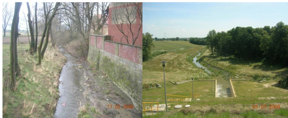
Rys. 3. Troja na dopływie do zbiornika (po lewej) i na odpływie ze zbiornika Włodzienin
