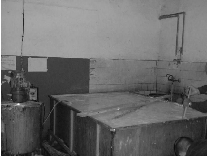
Fot. 2. Zbiornik na ścieki poprodukcyjne Photo 2. Post production wastewater tank
